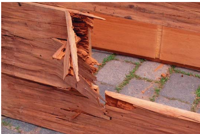
původní dno nakažené dřevomorkou
